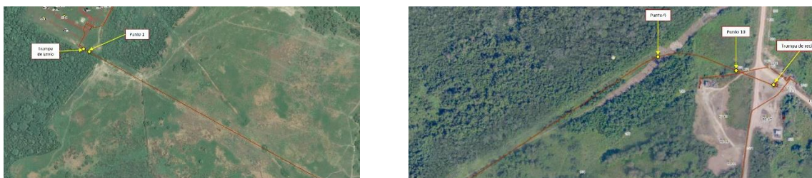
Figura 6. Localización de puntos de medición tomada de documento PI_102_Insp. Excavaciones Jibas 10in Rev.3 .
